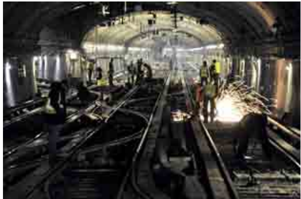
Travaux au niveau des circuits et des appareils de voie (moteurs qui commandent les aiguillages) pour l'automatisation de la ligne 1, station Château de Vincennes, 2010 © RATP-Bruno Marguerite
